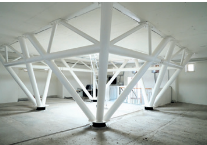
DETTAGLIO DEL SISTEMA TMD
