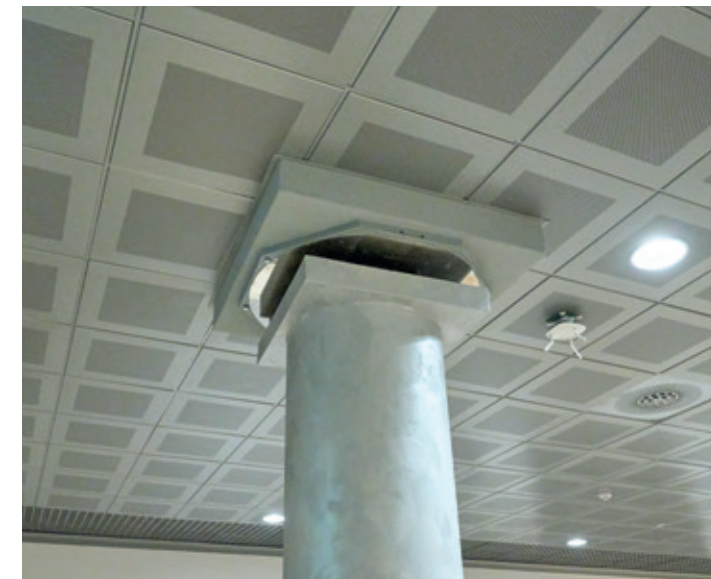
DETTAGLIO ISOLATORE ANTISISMICO
